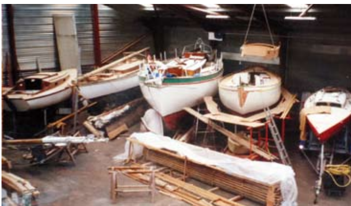
Vue du chantier Despierres au plateau nautique
