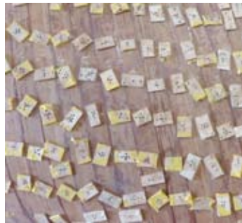
Vue de la technique de mise en pression provisoire des plis après le collage
