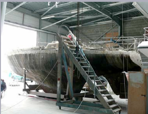
Damien en chantier (Photo Le Grand Pavois)
